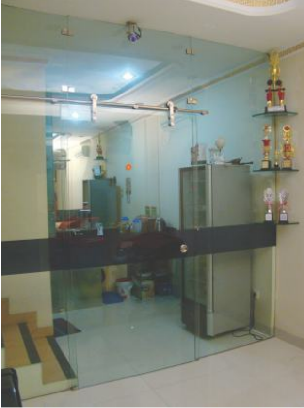
Fitting Sliding Door (Tebal Kaca 10 mm - 12 mm)
